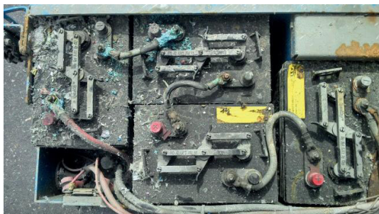
Defekte Batterien ersetzen
