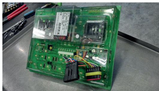
Reparatur an Steuerung
