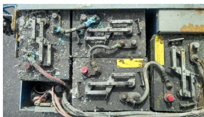
Defekte Batterien ersetzen
