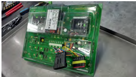
Reparatur an Steuerung
