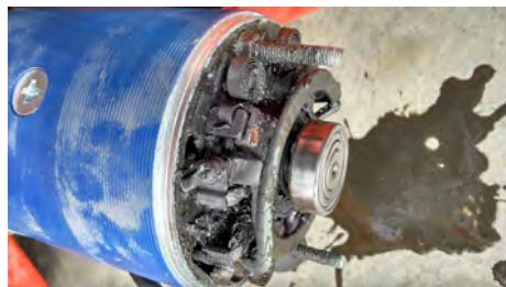
Wasserschaden an Antriebsmotor
