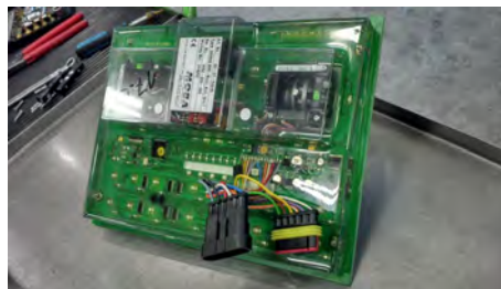
Reparatur an Steuerung
