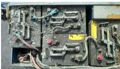
Defekte Batterien ersetzen
